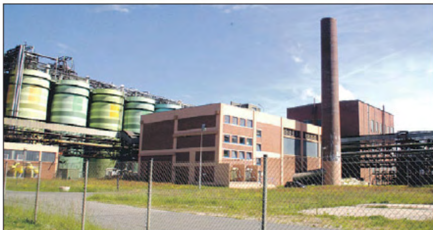
Eine verbindliche Erklärung der AOS zur Lärminderung machte den Weg für die Ausnahmeregelung zum Bau des eigenen Kraftwerks frei: Die Anlage mit Kraft-Wärme-Kopplung soll neben den alten Kesselhaus entstehen Foto: hr
